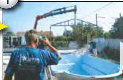
4 MISE À NIVEAU
