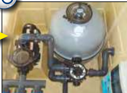
10 RÉALISATION DU LOCAL TECHNIQUE
