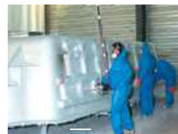
Pose des renforts + résine de protection
