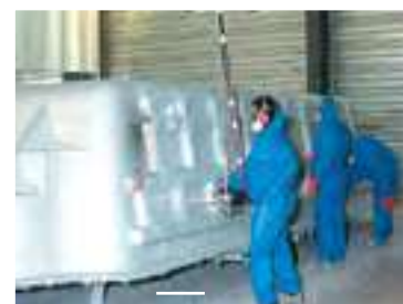
Pose des renforts + résine de protection
