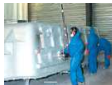
Pose des renforts + résine de protection
